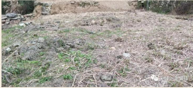
我家被拆掉的老房子的地基（戴启楼老师拍）
